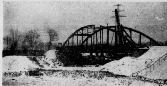
Die neue Saalebrücke von Söfopau.
