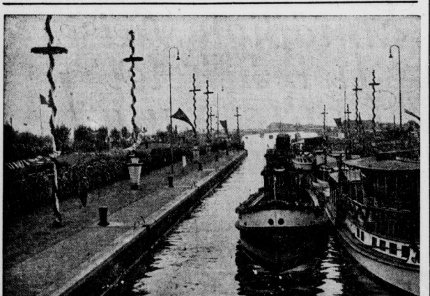
Eine der Schluessenanlagen des neuen Ems-Unterwieser-Kanals. Die letzte, 100 Meter lange Strecke des Küstkanals, der die Ems mit der Unterwieser verbindet, und die eine unbehinderte Verbindung mit dem Rheingebiet während der trockenen Sommermonate gewährleistet, wurde von Reichsverkehrsminister Freiherr Eilz v. Rübenach eingeweiht. Reichsstathalter Gauleiter Roever-Oldenburg und andere Vertreter der beteiligten Länder Oldenburg und Preußen nahmen an der Feier teil. Man sieht auf unserem Bild eine der beiden Schluessenanlagen während der Eröffnungsfeier. (Scherl-Bilderdienst-M.)
