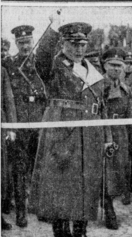
Ein Schwerthieb zerteilte das Band zur „Hermann-Göring-Brücke“. Unter dem Jubel der Bevölkerung weichte der preussische Ministerpräsident, General der Flieger Hermann Göring, bei Neuwied die neue Rheinbrücke auf seinen Namen ein. (Scherl-Bilderdienst-M.)
