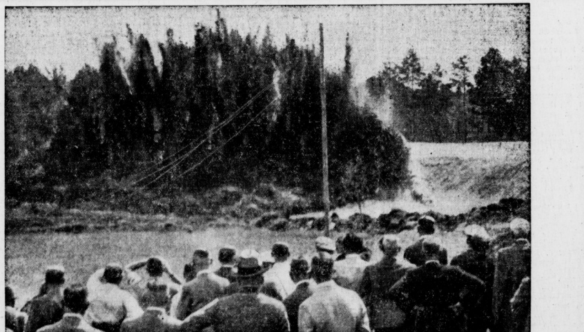
Die Straße der Reichsautobahn Berlin - Frankfurt a. d. O. führt in der Nähe von Kersdorf durch das Gollinger Moor. Um nicht ungeheure Moormassen zur Festigung des Untergrundes ausheben zu müssen, wurde das Moor, das stellenweise bis zu 20 Meter tief ist, gesprengt. Das neue Verfahren hat sich restlos bewährt. Unser Bild zeigt das Moorgebiet während der Sprengung. (Scherl-Bilderdienst-M.)
