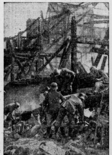
Pioniere halten bei den Aufräumarbeiten.
