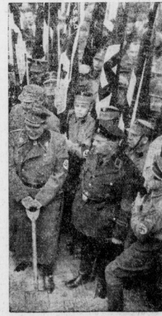
An der Autobahn Berlin-Stettin. Öbring beim ersten Spatenstich.
