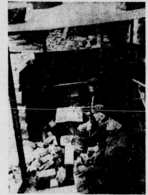
Überall regen sich Hände zum Wiederaufbau, um aus Schutt und Trümmern neue Werte zu schaffen. Aus den Beigen von Schuttmassen werden, wie unser Bild zeigt, die noch brauchbaren Ziegel ausgesucht und gepulvt. Aus ihnen wachsen die Mauern, die unsere neue Zeit baut.
