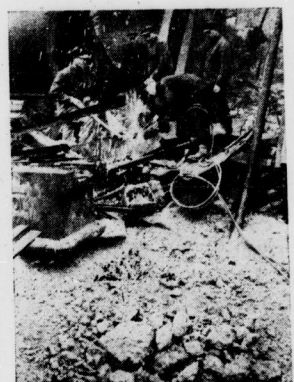
Schienengewitz am Bombentrichter
