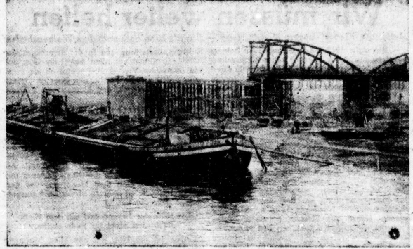
Im Zeichen friedlichen Aufbaues: Arbeit an der neuen Elbbrücke bei Torgau
