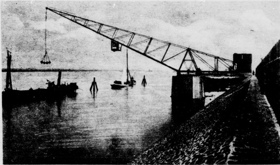
Moderner Drehkran in Spyl am Niederrhein. Ausladung 38 m Tragkraft 3 t
