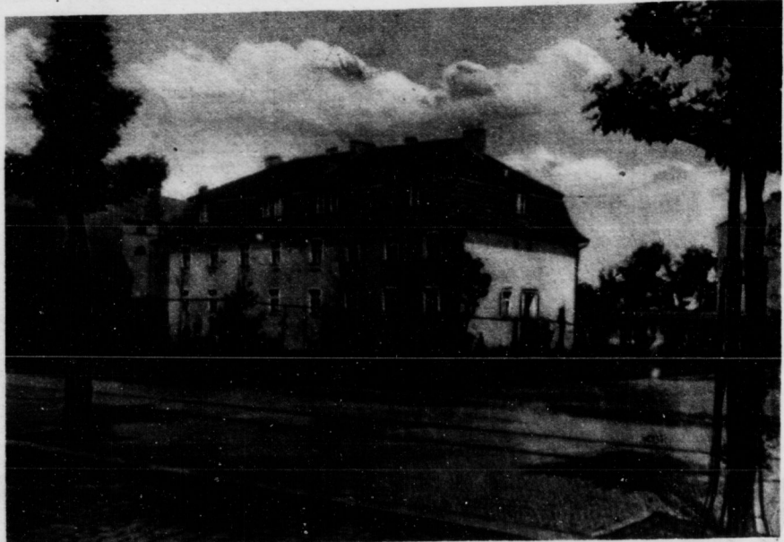
Ein neuer Gewerkschaftsban: Das in Charlottenburg errichtete Gebäude des Porzellanarbeiterverbandes
