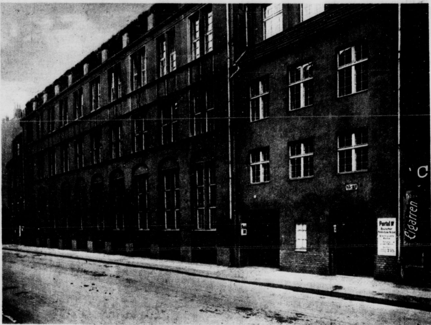
Die Front des Verbandshauses in der Linienstraße
