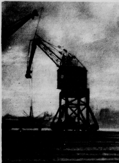
Vollportalcran im Hamburger Hafen der vor etwa acht Wochen abgebrochen wurde; die Tragfähigkeit des Krans betrug 3000 kg
