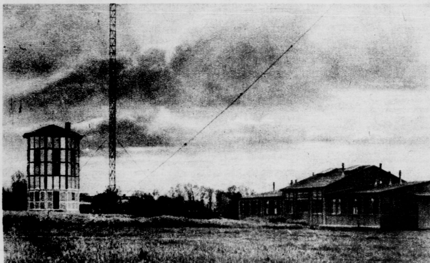
Empfangsanlage in Geltow
