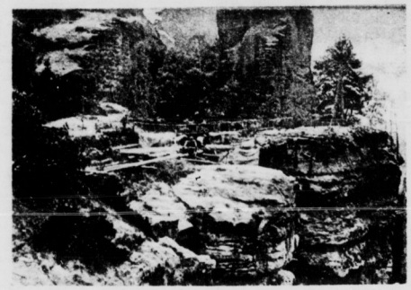
Brückenbauten im Abbruch
