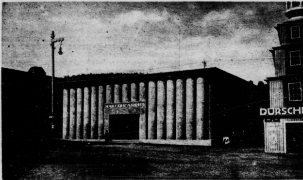
Das Haus der Arbeit
