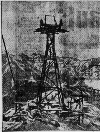
Blick von der Streda auf das zweite Stützgerüst der Seilbahn, das mit einer Entfernung von 1800 Metern von der ersten Stütze die größte Spannung der Seilbahn tragen wird.
