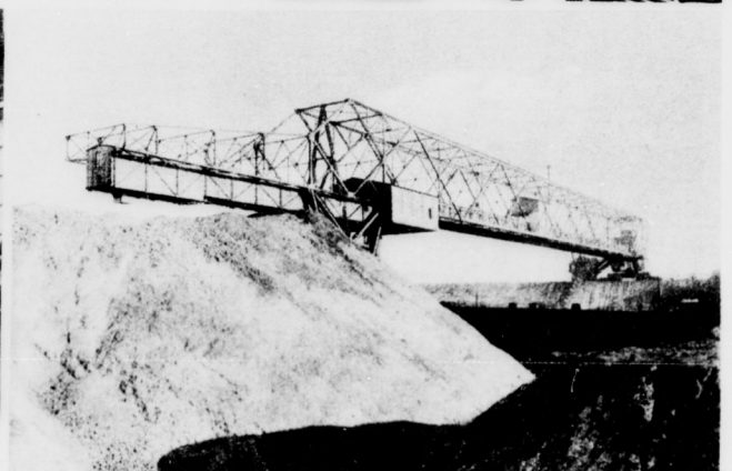
Unten rechts: Eine riesige Abraumbrücke für Braunkohlenförderung ist in den Pleßener Gruben im Betrieb. Die Brücke, die auf Geleisen steht, ist 125 Meter lang; Bandförderer schaffen das Abraumgut fort
