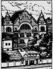
Außenseite am Adolfsplatzweg.
