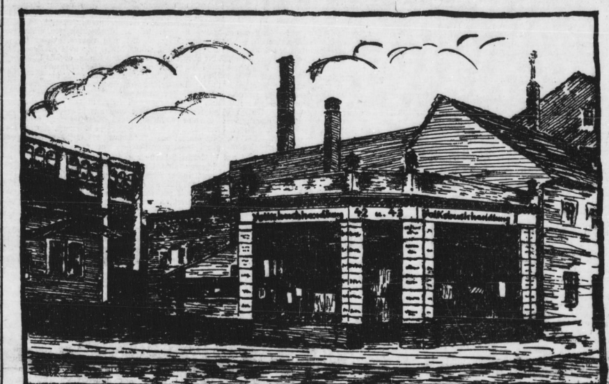
Im vor. Stock des Heeren Lebenshauses, nachdem die benachbarten Gebäude zerstört und abgerissen worden waren, ist im Jahre 1912/13 das moderne Betriebsgebäude, in dessen Fassade sich bis heute die Exposition des „Volksblatt“ befindet, dahinter das 1905 von der Genossenschaftsdruckerei erbaute Betriebsgebäude.
