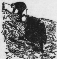
Im Bauschutt wird das Brennholz für den Tagesbedarf gefunden.
