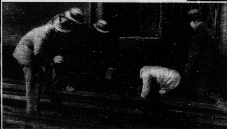
Den Streikbrechern werden die Stromzuführungen erklärt
