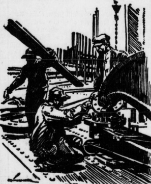
Der Verstellanker der Ritzanlage wird geprüft.
