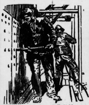
Ritzen an der Außenhaut mit Pressstiftmaschinen.
