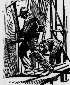
Der Verstellanker der Ritzanlage im Innern des Schiffes bei Ritzung der Hauptdeck.
