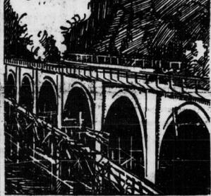
Ein Meisterwerk deutscher Technik ist der neue Rohna-Brückenturm der Sächsischen Eisenbahn, der im Sommer 1920 fertiggestellt wird. Die imposante Brücke hat neun Bögen mit 20 Meter Weite; sie ist 224 Meter lang, ihre Höhe über der Oberfläche beträgt 40 Meter.
