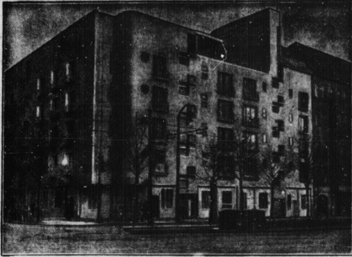
Der neue Poststil, ganz auf Zweckmäßigkeit eingestellt, kommt bei den Neubauten am Kaiserdamm in Berlin klar zum Ausdruck.
