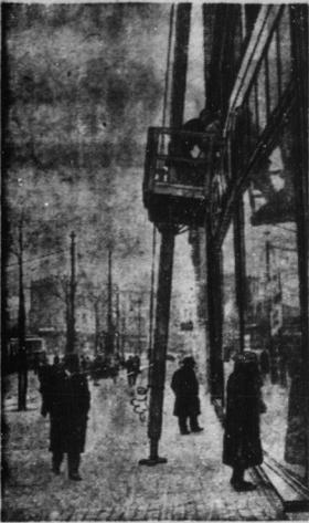
Die der Dipl.-Ing. Eine Säulenkonstruktion, findet in deutschen Großstädten zum Ausreifen von Fassfronten und Reigenen großer Fensteröffnungen mehr und mehr Verwendung. Der mit Stützen versehene Mast wird am Saume angebracht, und eine bewegliche Plattform, die zwei Personen Platz bietet, durch Seilband von den Arbeitern nach oben oben unten bewegt.
