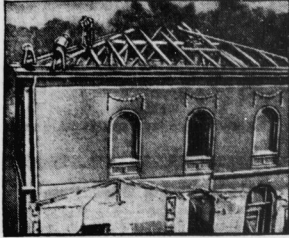
Der Abbau beginnt.
