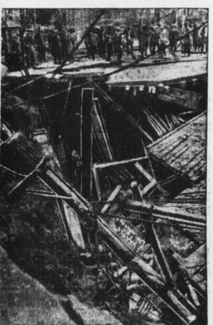
Stürze infolge anhaltenden Regens die Innenumauer einer Konstruktionsgrube. Das Bild zeigt die Trümmerstätte.
