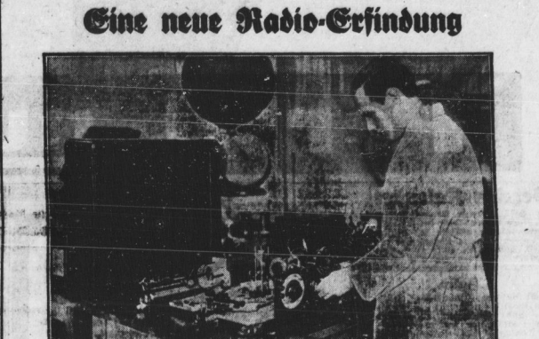
Manfred von Ardenne, dem bekannten Berliner Physiker, ist es gelungen, an einem Röhrenempfänger mit 1000 Volt Anodenspannung die hohe Spannung ungefährlich zu machen. Von Ardenne im Laboratorium.
