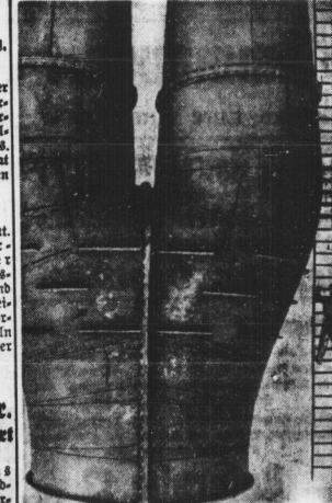
Eine neue Aufstellung deutscher Legehmit für ein solches fertiggestelltes, sogenanntes Hofenrohr ist das Krückerlein Rappin im Hofenbau. Die tiefen Dimensionen werden nicht anhaltend durch den auf der Seite stehenden Arbeiter.
