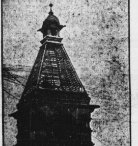
Die herabende Freileitung.
