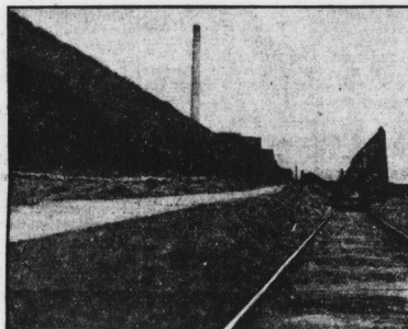
Im Hafenbecken I (im Bau).
