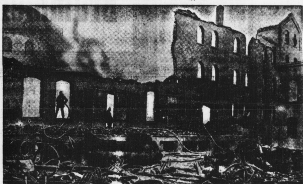
Der bis auf die Grundmauern angebrannte Gebäudekomplex der hannoverschen Kumpenfabrik. Der Funkenregen stieg fast 100 Meter hoch in den Himmel; der Brand hatte eine Ausdehnung von mehr als 500 Meter, so daß ganze Straßenzüge schwer gefährdet waren.
