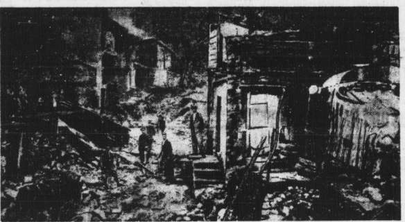
Häuser in Smyrna, die von einer Felslawine zerstört wurden. Durch die wolkensartigen Regenfälle, von denen Smyrna schwer heimgesucht wurde, stürzten riesige Felsblöcke eines Berges am Rande der Stadt, wuchsen zu einer Lawine an und begruben in raschem Fall alles unter sich, was ihnen im Wege kam. 134 Menschen wurden von den Steinen erschlagen, zahllose Häuser zerstört, 3000 Menschen wurden obdachlos.
