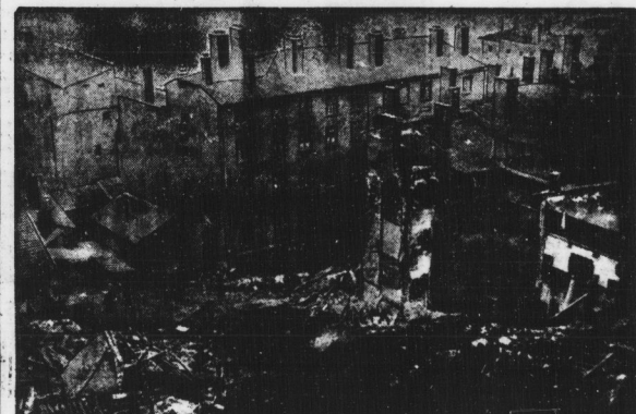
Nebensicht über die Gassenansicht im Viertel Fourvières.
