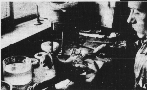
Bekleben einer Bronzefigur mit Metallfolie zur Entfernung schädlicher Patina
