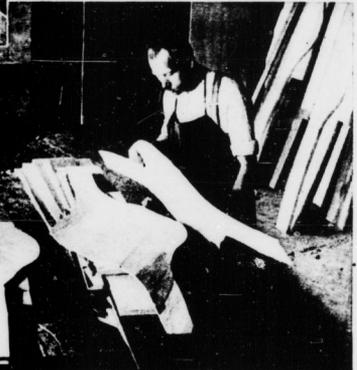
Am Kontrollapparat wird der fertiggestellte Propeller auf die vorgeschriebenen Größenverhältnisse nachgemessen
