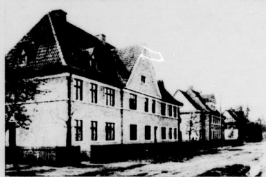
Oben: Mehrfamilienhäuser in der Siedlung Güsten
