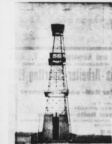
Petroleumbohrturm Edesse 1 in der Lüneburger Heide (Hannover). Die Bohrung wird vom preußischen Staat ausgeführt und ist binnen weniger Monate 900 Meter tief getrieben worden.
