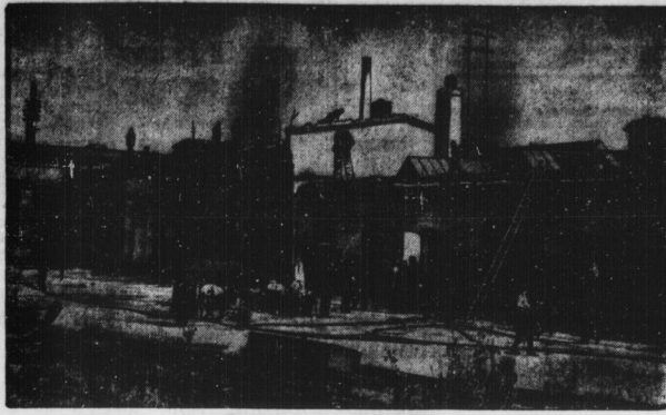
Das ausgebrannte Fabriksgebäude.
