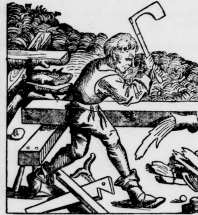
Zimmermann bei der Arbeit Holzschnitt von M. Wohlgemuth. (1493).
