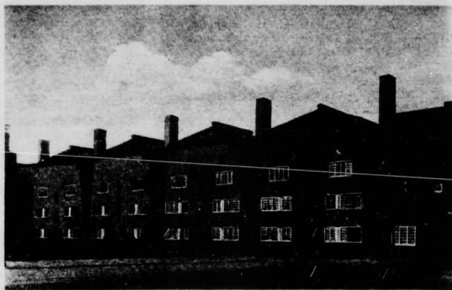
Wohnungen der Gemeinnützigen Wohnungsbaugewerkschaft „De Dageweb“
