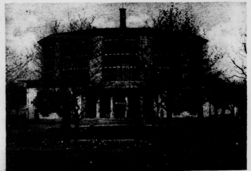
Die neue Ausstellungshalle in Gelsenkirchen Die größte Kohlenstadt des Kontinents, Gelsenkirchen, besitzt jetzt nach Fertig- stellung der neuen Ausstellungshallen eine der größten Holzbaufunktions- Rundhallen der Welt
