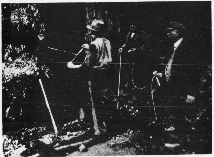
Vorbereitung zum Sprengen eines Braunkohlenblocks
