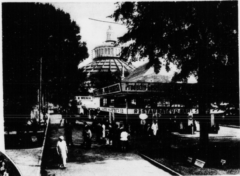
Ein Teil des Wiener Messengeländes; im Hintergrunde: Die Halle der Rotunde
