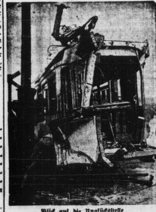
Bild auf die Unglücksstelle. In Hannover ereignete sich ein schwerer Zusammenstoß zwischen einem Straßenbahnwagen und einem Güterzug, der über die Straße rangiert wurde. Die vordere Plattform des Straßenbahnwagens wurde nach hinten umgeworfen und einige Fahrgäste erheblich verletzt.
