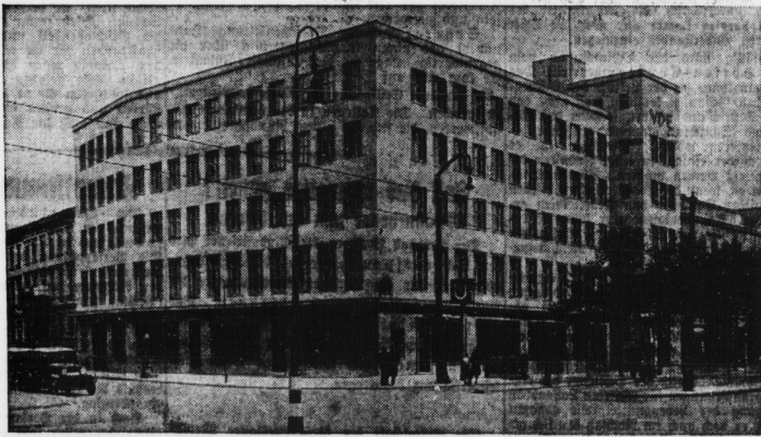
Das neue Geschäftshaus des VDE. (Verband deutscher Elektrotechniker) in der Bismarckstraße in Berlin-Charlottenburg.
