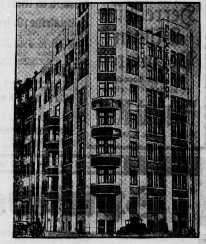
Die Moskauer Konsumgenossenschaften haben sich ein eigenes Wollenträger gebaut und einen Wollenträger im modernsten allerding primitiven Stil errichtet. Das Haus zählt zehn Stockwerke und ist damit das höchste Moskauer Haus im allgemeinen die Häuser Moskau nach drei bis vier Stockwerke. Unterhalb des ersten Wollenträgers, das Konsumgenossenschaftsgebäude in Moskau.
