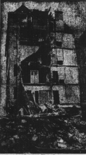
Das zerstörte Haus.
