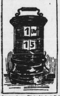
Das ist in einem Glasgehäuse befindliche Uhrzeit zeigt durch Blätter die verstrichenen Stunden und Minuten selbständig an.
