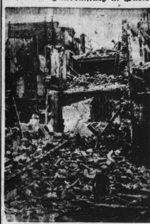
Die Anglistische in der Rue Montmartre. Im Zentrum des alten Paris ereignete sich ein schwerer Hauseinsturz, bei dem 3 Arbeiter unter Trümmern erschüttert wurden. Erst nach langer Arbeit konnten die Unglücklichen befreit und in ein Krankenhaus gebracht werden.
