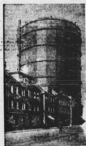
In Stuttgart wurde ein neuer Calomel in Betrieb genommen, der 405 Meter hoch ist und 332 000 Kubmeter Gasraum hat.
