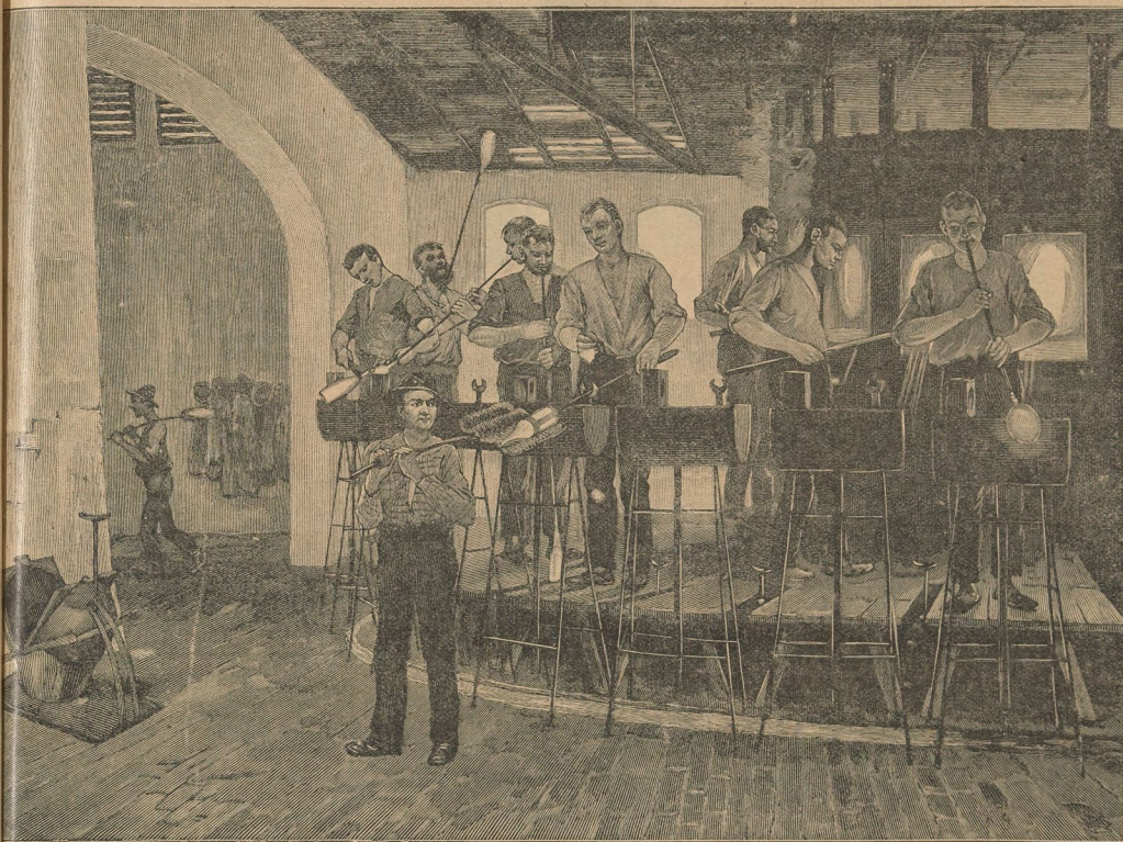
In der Glasfabrik: Herstellung von Weinflaschen.
